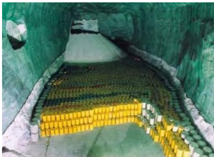
شکل ۱. مرکز دفن ضایعات هسته‌ای در گنبد نمکی
