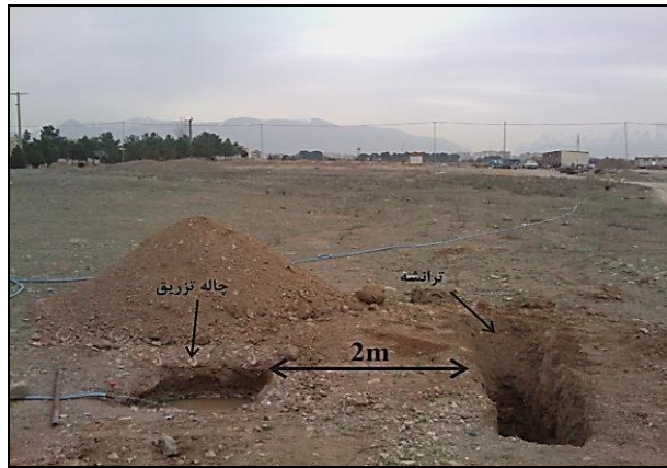
شکل ۸. نمایی از ترانشه حفر شده در ۲ متری چاله تزریق (دید از غرب به شرق)
