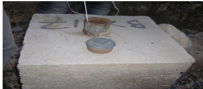
شکل ۳. تصویر کلی یک پیزومتر
