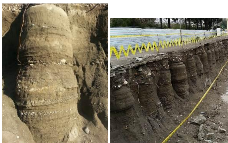
شکل ۶. برداشتن خاک اطراف ستون‌ها به‌منظور کنترل قطر
