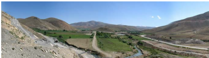
شکل ۵. نمایی از گسترش کف‌بند طبیعی در بستر مخزن (دید به سمت جنوب از تکیه‌گاه راست)
