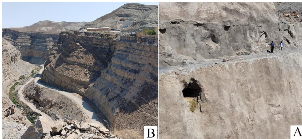
شکل ۹. A) حفره (غارچه) انحلالی آهک‌های سازند تیرگان در امتداد شکستگی‌ها در جناح چپ سد (دید به شمال)، و B) دره کارستی پایین دست سد (دید به شرق).
