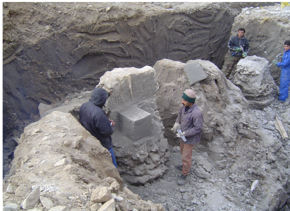
شکل ۲. ستون‌های خاک-سیمان به همراه نمونه‌های بلوکی برای گمانه‌های تزریقی T2, T3, T5 [۱۵]
