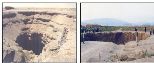
شکل ۷. تصویر فروچاله اختیار آباد شکل ۸. تصویر فروچاله چاه دریا
