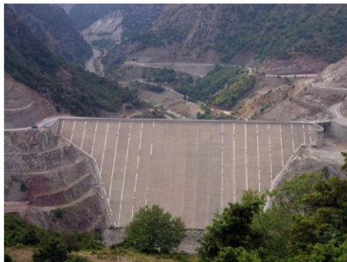
شکل ۱. الف) مقطع و ب) نمای سد مسوچورای یونان به‌عنوان نمونه‌ای از سدهای سنگریزه‌ای با روکش بتنی [۴]
