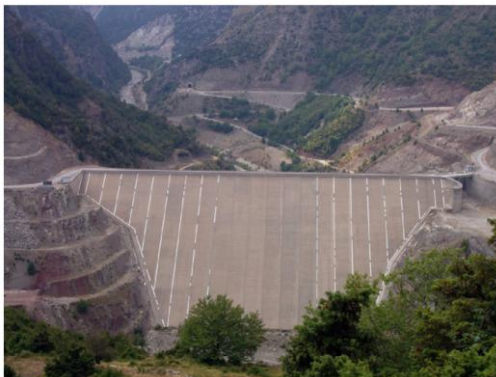
شکل ۱. الف) مقطع و ب) نمای سد مسوچورای یونان به‌عنوان نمونه‌ای از سدهای سنگریزه‌ای با روکش بتنی [۴]
