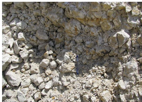
شکل ۴: خردشدگی شدید توده‌سنگ در بخشی از ترانشه سرریز
