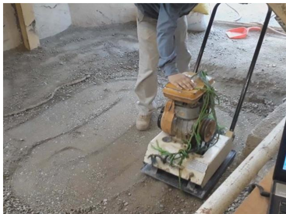
شکل ۴. تصویری از کوبیدن بستر با کمپکتور بنزینی
