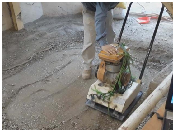
شکل ۴. تصویری از کوبیدن بستر با کمپکتور بنزینی
