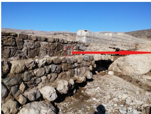
شکل ۳. هوازدگی نمک در سنگ‌های استفاده شده در پایه یکی از پل‌های منطقه مورد مطالعه
