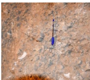
شکل ۹. سیمان‌تاسیون آبرفت‌ها در تونل حفاری‌شده در محدوده بررسی شده
