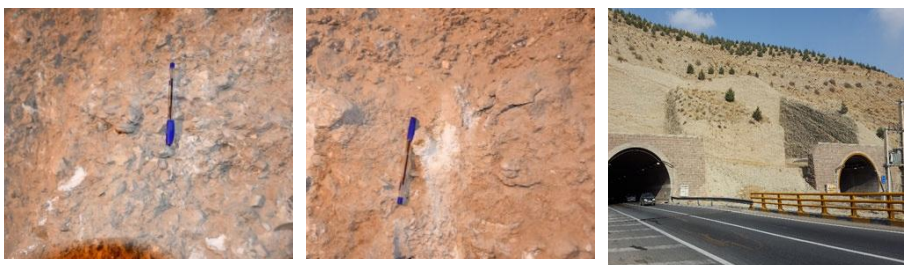
شکل ۹. سیمان‌تاسیون آبرفت‌ها در تونل حفاری‌شده در محدوده بررسی شده
