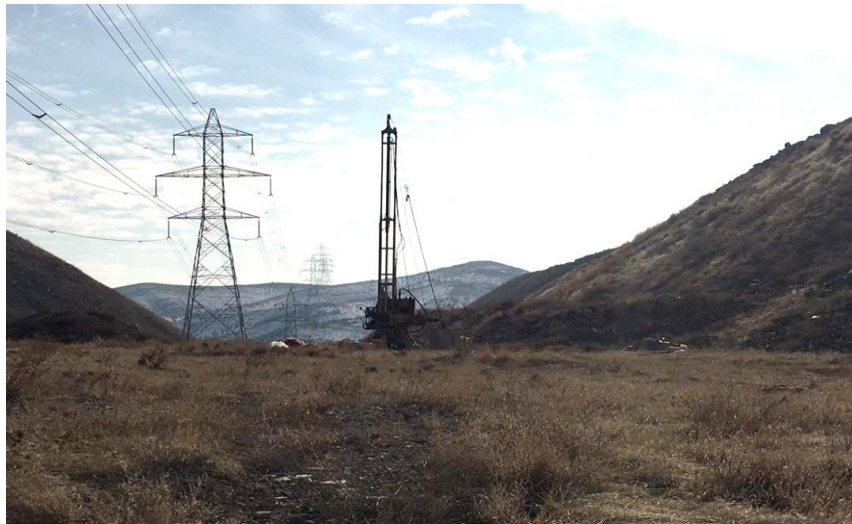
شکل ۶- عملیات حفاری در منطقه مورد مطالعه
