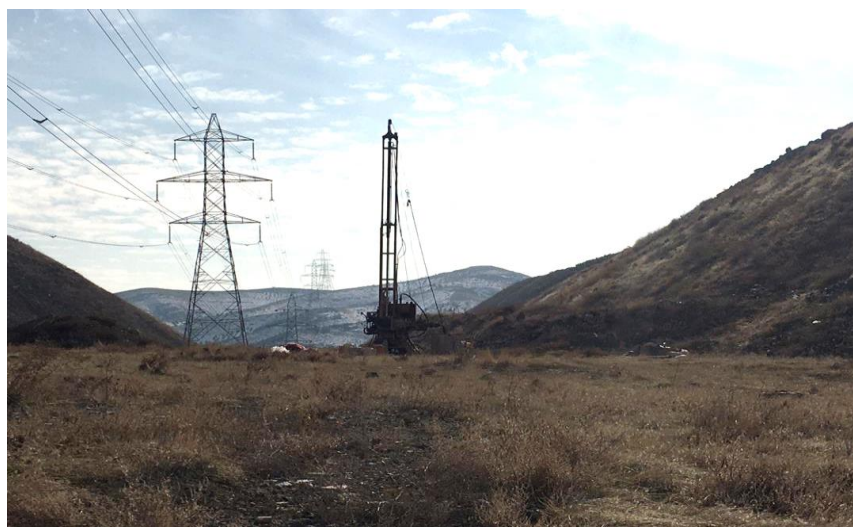
شکل ۶- عملیات حفاری در منطقه مورد مطالعه
