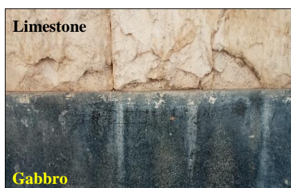
شکل ۳. آسیب زیباشناختی به سنگ نمای ساختمان به دلیل برخی فرایندهای زوال مانند آلاینده‌های اتمسفری و شوره‌زدگی
