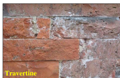
شکل ۳. آسیب زیباشناختی به سنگ نمای ساختمان به دلیل برخی فرایندهای زوال مانند آلاینده‌های اتمسفری و شوره‌زدگی
