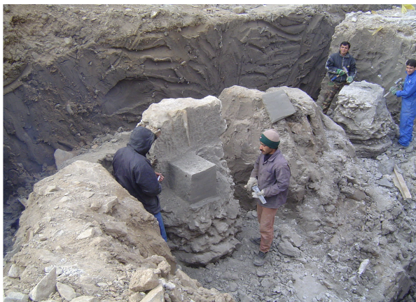
شکل ۲. ستون‌های خاک-سیمان به همراه نمونه‌های بلوکی برای گمانه‌های تزریقی T2, T3, T5 [۱۵]
