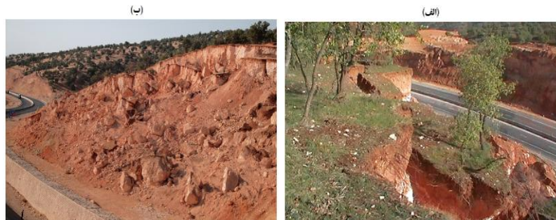
شکل (۲) لغزش داد آباد در ترانشه های مشرف به جاده بر اثر جاده سازی، کیلومتر ۲۲ جاده مطالعاتی، دید به جنوب غرب (الف)، لغزش آب بید به طول ۳۲۰ متر در دامنه های مشرف به جاده که باعث تغییر مسیر اصلی جاده و ایجاد پیچ تند شده است، دید به شمال شرق (ب)
