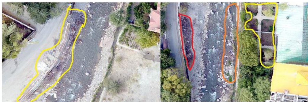
شکل (۴). تخریب پوشش گیاهی، وجود موانع طولی و جانبی و تغییر مسیر رودخانه در بازه ۱
