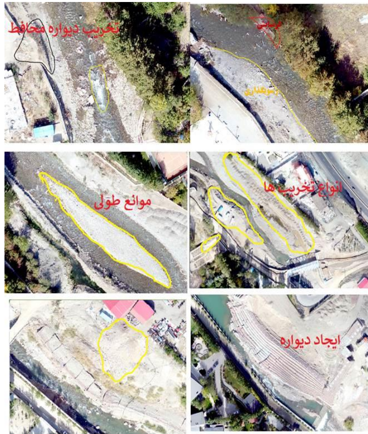
شکل (۱۱). رسوب گذاری و فرسایش در بازه ۴
