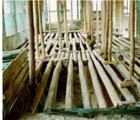
شکل (۷). سقف تیر پوش چوبی در تبریز با رعایت همپوشانی و یکپارچه سازی برای حفظ زلزله منبع: فخا، ج، تهران، ۱۳۸۵
