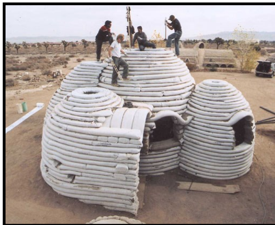
شکل (۱۱). خانه ابر خشت ساخته مرحوم مهندس نادر خلیلی - مناسب برای مقابله در زلزله، سیل طوفان (خلیلی، ۱۳۸۳)
