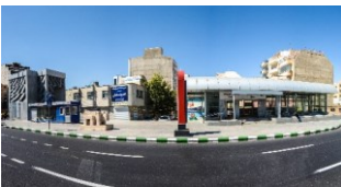
شکل (۸). ناهماهنگی بدنه ایستگاه مترو
