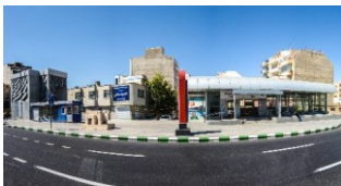
شکل (۸). ناهماهنگی بدنه ایستگاه مترو
