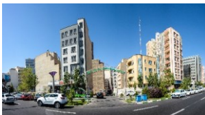
شکل (۷). ناهماهنگی مصالح ساختمان‌ها
