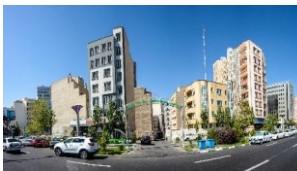
شکل (۷). ناهماهنگی مصالح ساختمان‌ها
