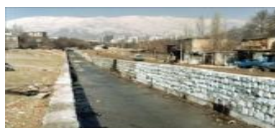
شکل (۲). تصاویر وضع موجود رودره درکه
