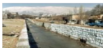
شکل (۲). تصاویر وضع موجود رودره درکه
