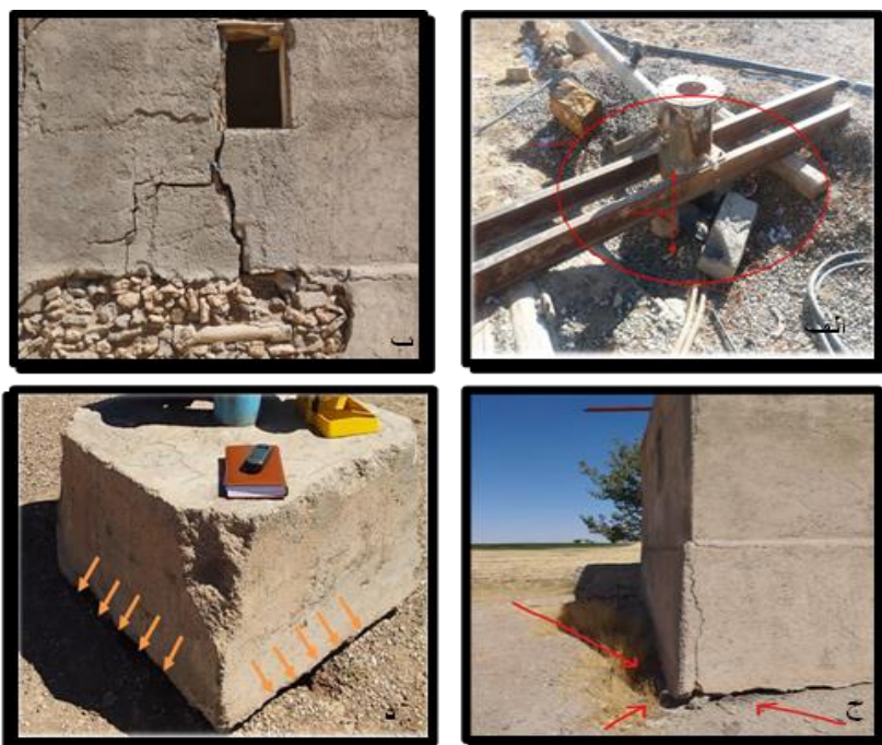
شکل ۹. الف) فرونشست سطحی در جداره لوله چاه بین دشت قروه و دهگلان (ب) ترک خوردگی در دیواره خانه چاه روستایی کروندان (ج) نمایان شدن فرونشست در حاشیه خانه‌های مزرعه روستای کروندان (د) پایین رفتن سطح زمین و ارتفاع یافتن پایه‌های نمونه پایش فرونشست در روستای شهابیه
