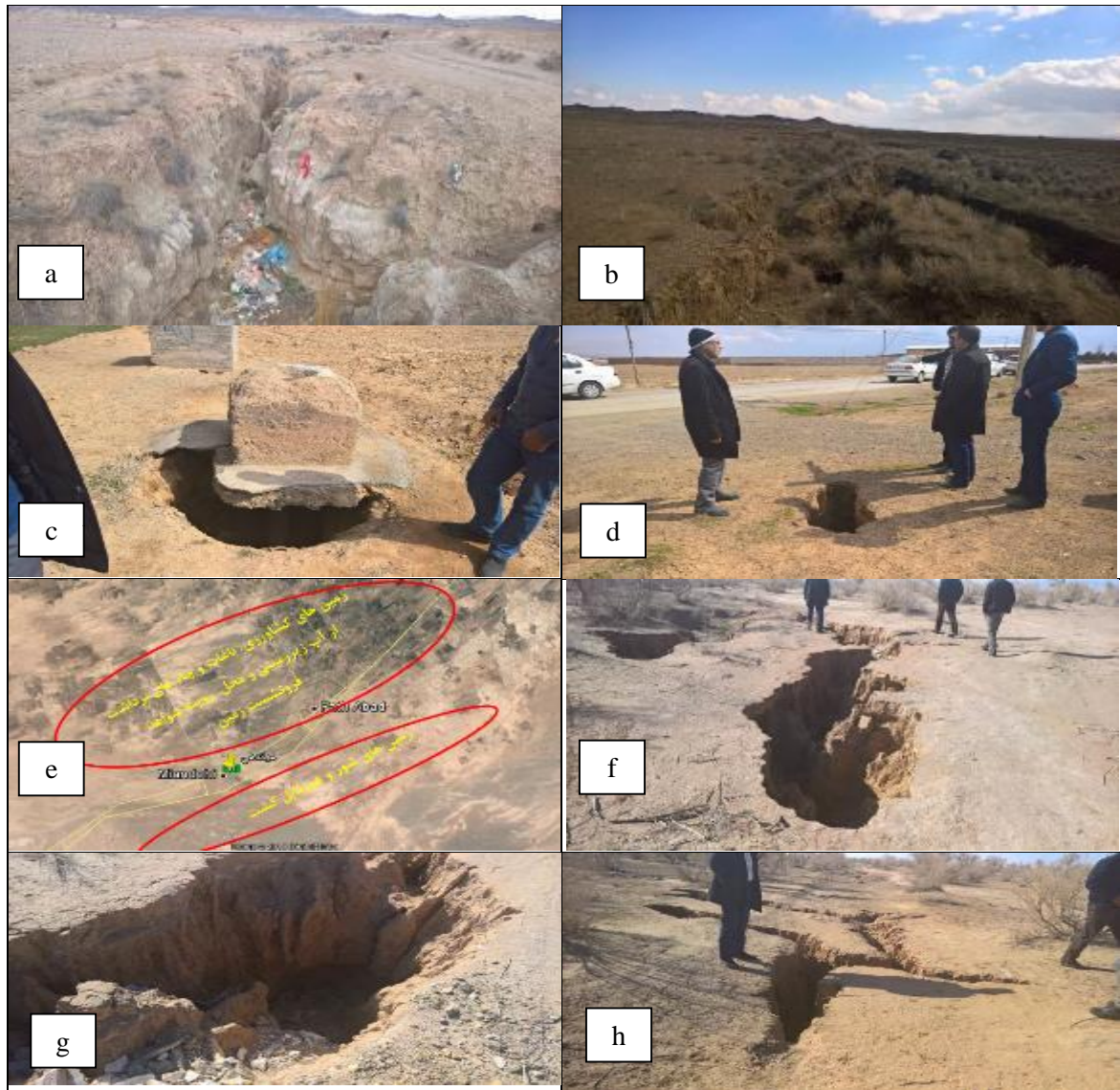
شکل ۱۶: a، b، c، d: شکاف ها و فروچاله ناشی از فرونشست زمین در روستای سلطان آباد، e، f، g و h: شکاف ها و فروچاله ناشی از فرونشست زمین در روستای میاندهی
