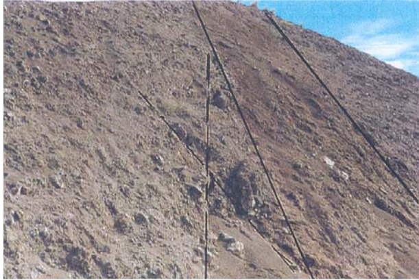
ب) شکستگی با موقعیت N 30 W در رسوبات مخروط افکنه شمال غربی ده زونیه
